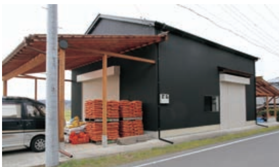
八乙女営農組合資材倉庫▶
