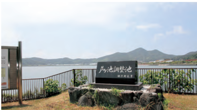
▲豊川用水芦ヶ池調整池
